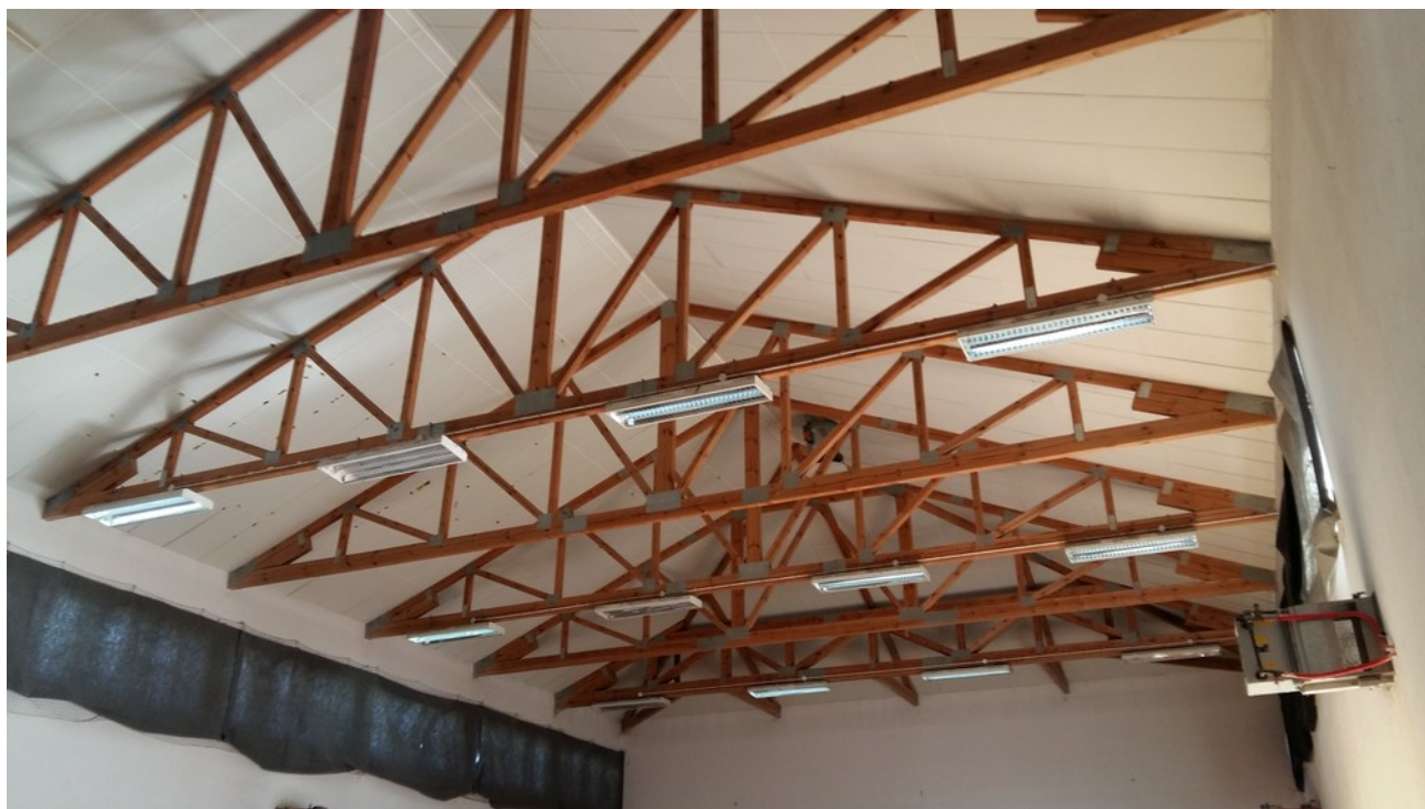
Zdj. nr 4: Istniejąca konstrukcja dachu nad salą sportową.
